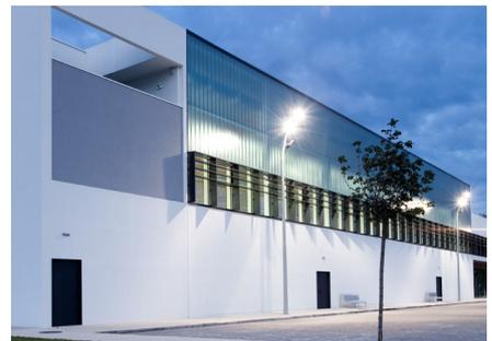
qualité environnementale : bâtiment à forte inertie • production ECS par capteurs solaires • enveloppe performante : isolation par l'extérieur, vitrages basse émissivité, brise soleil • toiture végétalisée • confort visuel (éclairage naturel)
