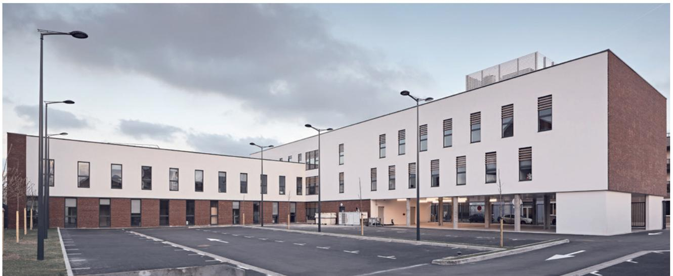
qualité environnementale : objectif de consommation : RT 2005 - 50 % (BBC) • bâtiment à forte inertie • toiture végétalisée • enveloppe performante (façades double peau) • système innovant de traitement thermique des bureaux soufflage par faux plancher, pré traitement de l'air par patios intérieurs
