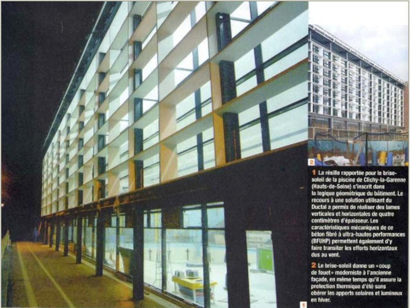
**1** La résille rapportée pour le brise-soleil de la piscine de Clichy-la-Garenne (Hauts-de-Seine) s'inscrit dans la logique géométrique du bâtiment. Le recours à une solution utilisant du Ductal a permis de réaliser des lames verticales et horizontales de quatre centimètres d'épaisseur. Les caractéristiques mécaniques de ce béton fibré à ultra-hautes performances (BFUHP) permettent également d'y faire transiter les efforts horizontaux dus au vent.
