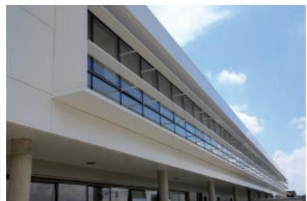
qualité environnementale : objectifs de consommation : 80 kWh/an/m<sup>2</sup> - respect de la RT2005 - 15% • enveloppe performante : isolation par l'extérieur, brise soleil, vitrages basse émissivité • toiture végétalisée • rafraîchissement par pompes à chaleur air-air, principe de free-cooling
