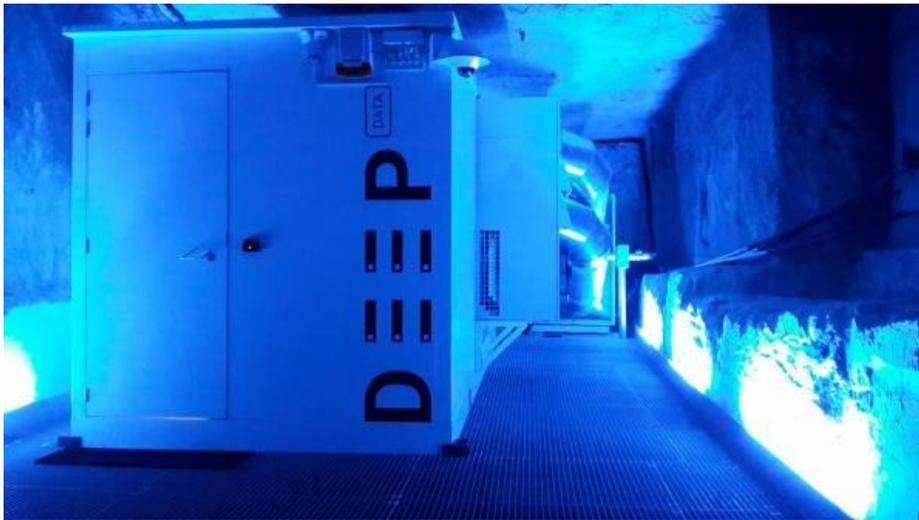
**Après 3 années d'expérimentation, le consortium Deep Data a dévoilé les résultats de son data center expérimental souterrain installé dans une galerie troglodyte du Saumurois. Une première mondiale qui utilise la fraîcheur et la stabilité thermique des caves pour réduire la facture énergétique. La commercialisation devrait démarrer au premier semestre 2017.**
